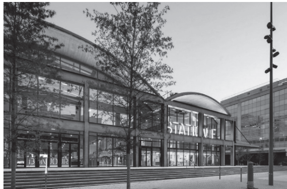
写真-1 駅舎の名残りが感じられるスタートアップ支援施設の「Station F」
